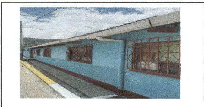
Foto 5: SUSTITUCION DE BAJADA DE AGUA PLUVIAL
